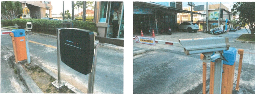
รูปภาพที่ 2.16 ระบบควบคุมการเข้า-ออก (Access Control) และระบบกล้องโทรทัศน์วงจรปิด (CCTV)
