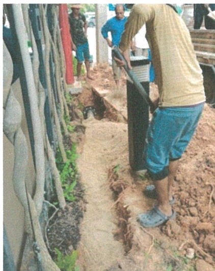
รูปภาพที่ 2.2 การตรวจสอบรอยร้าวของท่อประปา
