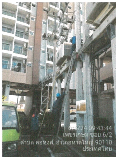
รูปภาพที่ 2.30 การตรวจสอบหม้อแปลงไฟฟ้า
