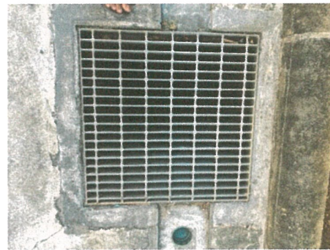
รูปภาพที่ 2.42 ตะแกรงดักมูลฝอย
